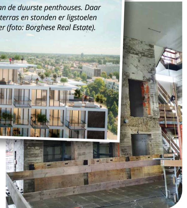
De toegang naar de liften op de begane grond vanaf de hoofdingang. De eerste etage is 'weggeknipt'. Het gebouw kent straks geen 12 maar 11 etages (foto: Hans Nijenmanting).
